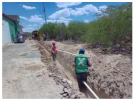
En la privada 18 de marzo se amplió la red de agua potable y drenaje sanitario, debido a que no contaban con estos servicios. Se instalaron 84 metros lineales de tubos 2" PVC para línea de distribución de agua y tubos de 8" ADS corrugado para drenaje sanitario, invirtiendo un total de \$71,640.45 beneficiando a 16 personas.
