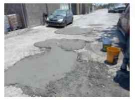
Las calles de la Cabecera Municipal necesitan constante rehabilitación, en ocasiones debido a las rupturas de concreto por contratos de drenaje y/o fugas de agua se generan baches, en este segundo periodo se rehabilitó un total de  $109m^2$  de bacheo a base de concreto hidráulico, invertimos un total de \$53,719.60, en cuanto al bacheo de calles con asfalto se invirtieron \$65,940.00, en beneficio de 8,646 personas de la Cabecera Municipal.
